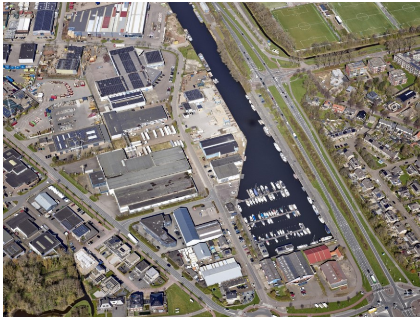
Foto 7: Bedrijventerrein Lagedijk van bovenaf gezien
