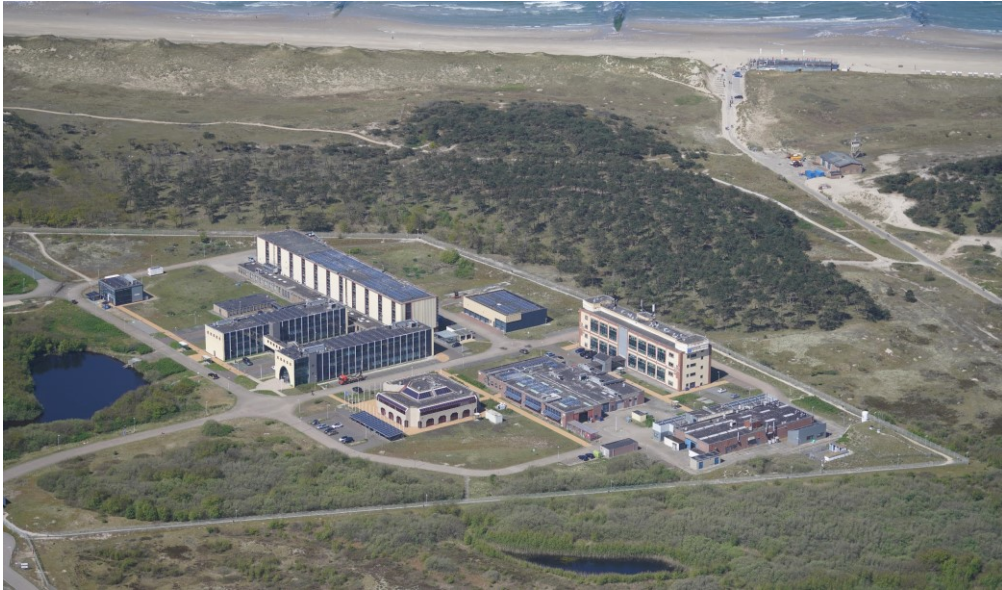
Foto 3: Energy & Health Campus van bovenaf
