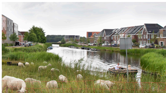
Westerdel, Dijk en Waard
